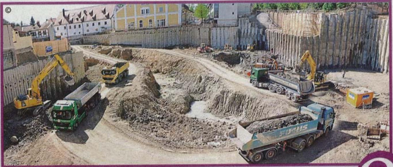
Bevor mit dem Aushub der Baugrube begonnen werden konnte, mussten rund 400 der 50 bis 80 cm dicken Betonpfähle gesetzt werden. Die Hanglage des Grundstücks aber auch die Tiefe des Gebäudekomplexes machten dies notwendig. Um mit den Lkw-Reifen möglichst wenig Kies und Schmutz auf die Straßen zu bringen wurde eigen ein Fundament errichtet und eine Reifenwaschanlage aufgestellt.
